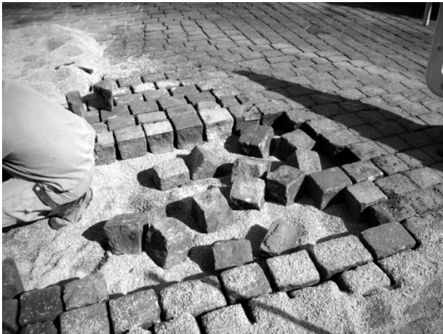
石畳の修復作業の様子
